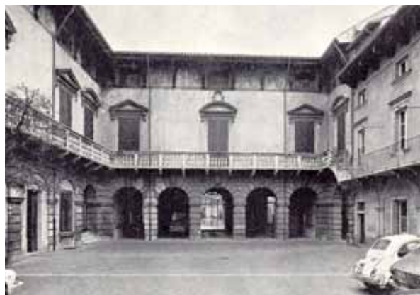
Palazzo Murari della Corte Brà (cortile interno su via S. Nazaro)
